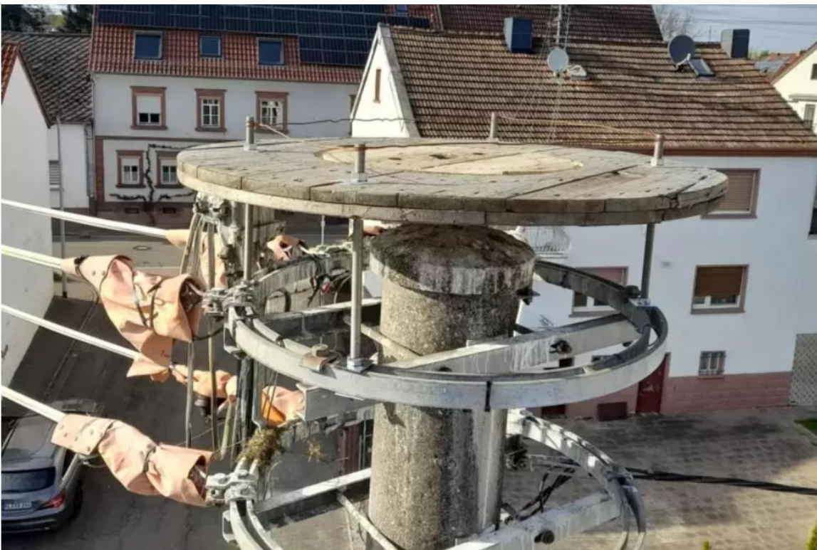
Entgegenkommendes Angebot: Die Stadtwerke Ramstein haben ein Podest auf dem Mast installiert, auf dem die Störche relativ sicher brüten könnten. | Foto: Stadtwerke Ramstein/oho
